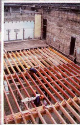
Trabajos en el ala Sur del Patio de Letras.
